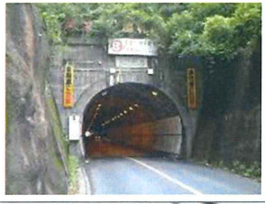
青影トンネル
